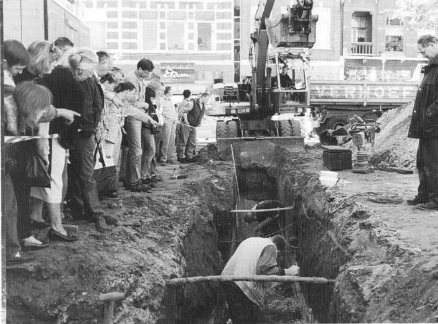
Graafwerkzaamheden op het Raadhuisplein.
