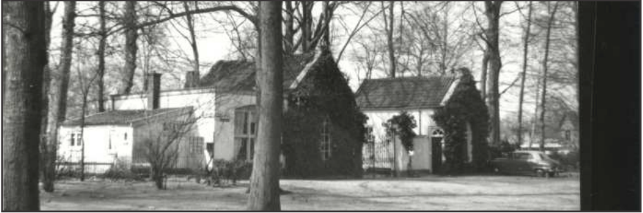
Ingang voormalige begraafplaats aan de Loolaan, 1960 | Bron: CODA Archief
