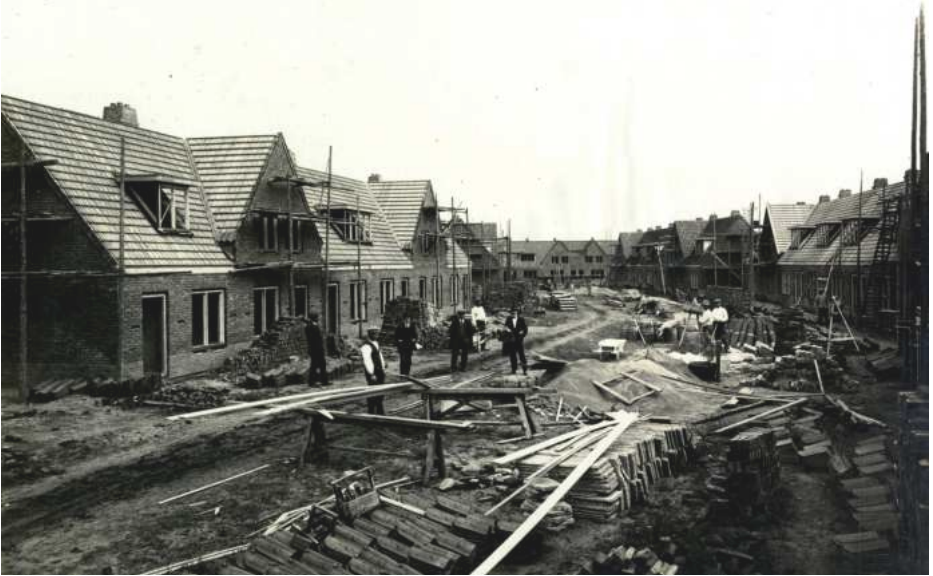
Bouw van de Wolweg in het Sprengendorp, ca. 1923 | Bron: CODA Archief
