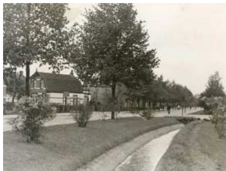
Sprengenweg bij het Julianaziekenhuis met beek; de beek is behandeld met gestabiliseerde klei. Links de Bartelsweg | 1939
