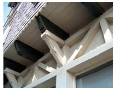
Door de glasstroken tussen de uitragende vloerbalken te herstellen, strijkt het daglicht weer langs het plafond van de winkel.
