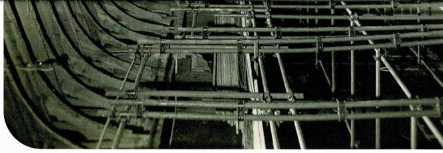
Steigerwerken in de zaal van Minerva tijdens een grote verbouwing in het voorjaar van 1942 (coll. CODA).
