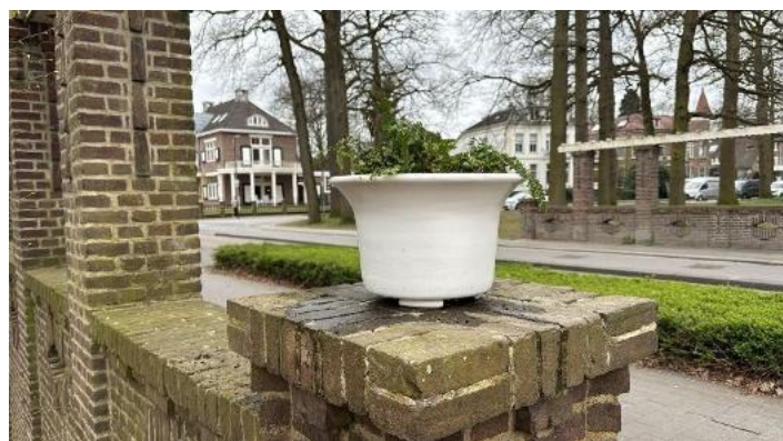
(foto: Renovatie bruggen Oranjepark)
